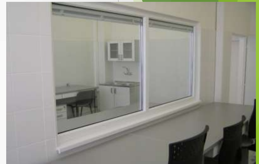
Výstavba nového mikrobiologického a imunologického laboratória
