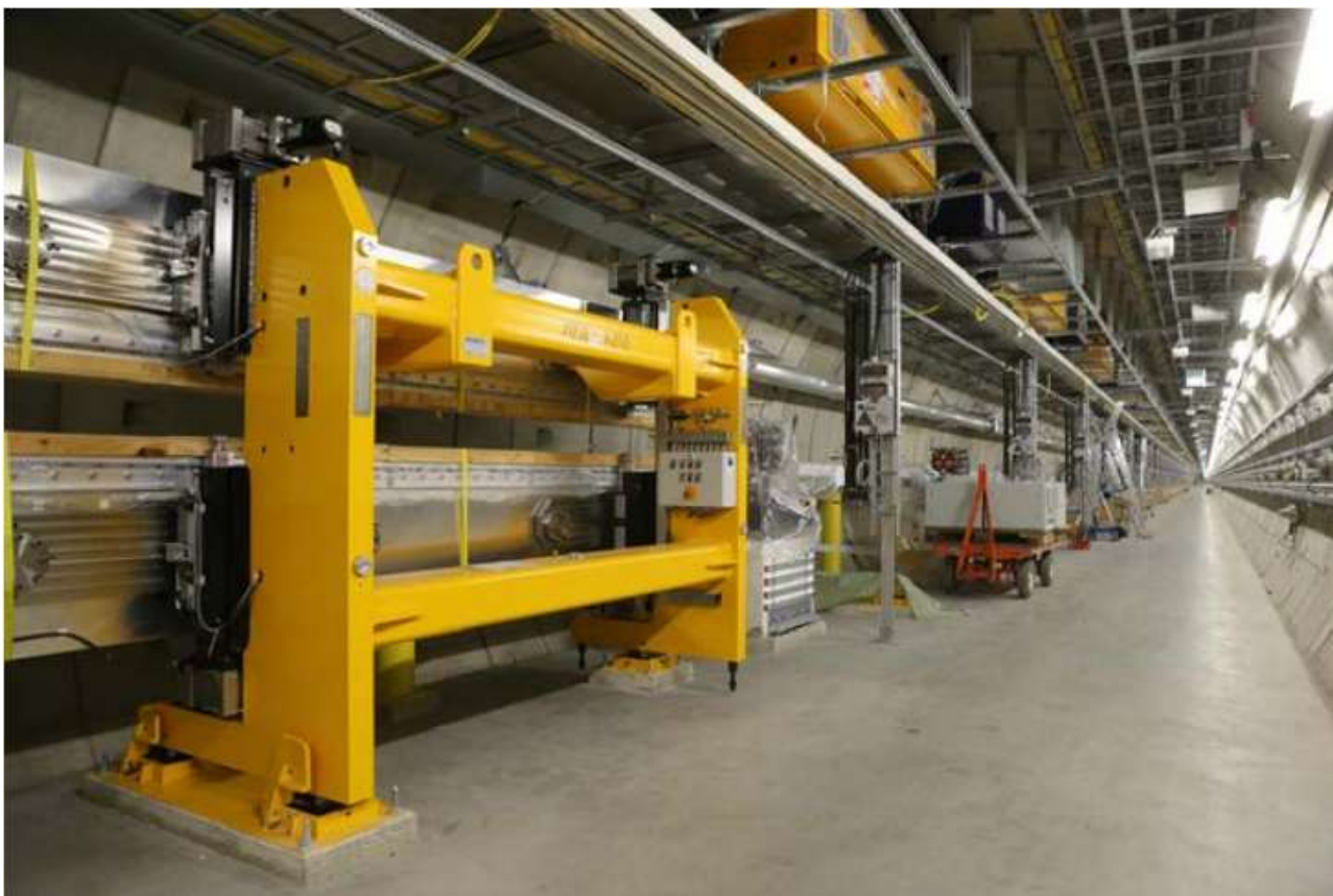
Pohľad do SASE1 fotónovo elektrónového tunela, s prvým inštalovaným 5 m dlhým undulátorom. Konečný počet undulátorov v tomto tunely bude 35.
