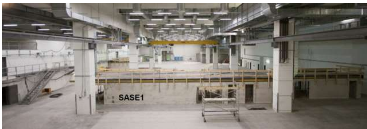
Pohľad do SASE1 fotónovo elektrónového tunela, s prvým inštalovaným 5 m dlhým undulátorom. Konečný počet undulátorov v tomto tunely bude 35.
